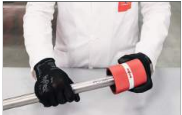
Sbavatura del tubo / Deburring the pipe
