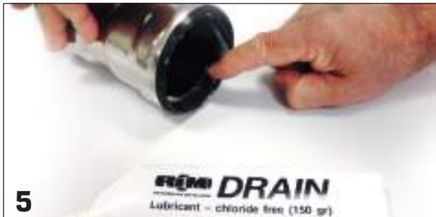
5 Lubrificazione zona interna guarnizione / Internal gasket lubrication
